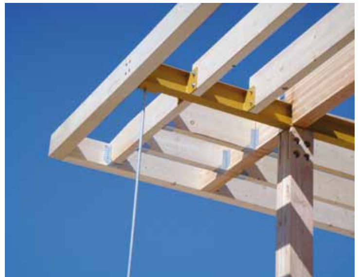
IPN métallique de l'angle de la toiture. Une poutre métallique porte la toiture. Le balcon est porté par la suspenste de débord de toiture qui flotte pour donner de la légèreté au bâtiment.
