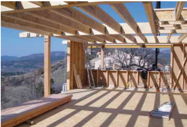
Les poutres en I de la toiture permettent de réaliser des caissons pour isoler la toiture en liège en vrac. Les poutres en I offrent une grande portée et suppriment les ponts thermiques.
