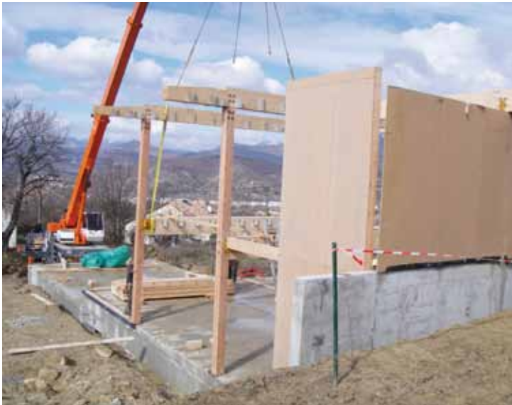
Une grue monte la structure (portiques bois).
