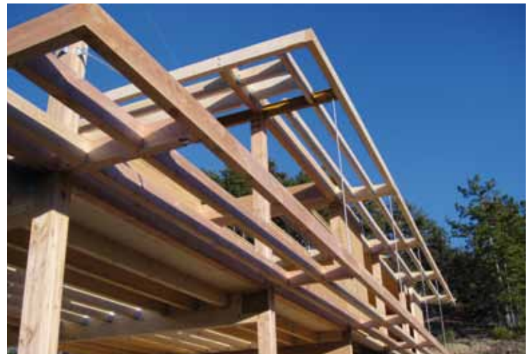
Ensemble de la structure du bâtiment, les balcons suspendus, les poteaux-poutres.
