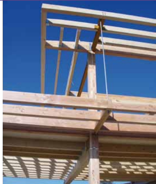
Débord de toiture. Un IPN (poutre métallique à Profil Normalisé en I) qui porte le débord de toiture et un tirant métallique qui permet de suspendre le balcon.
