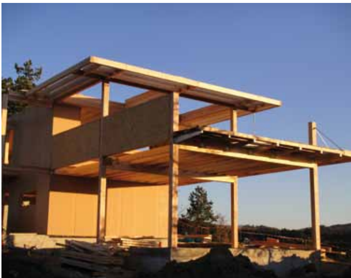
En haut, des poteaux-poutres reprennent la toiture.
