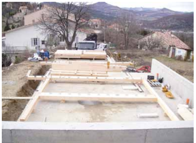
Dalle béton prête. Assemblage du poteau-poutre. Structure prête à être levée.
