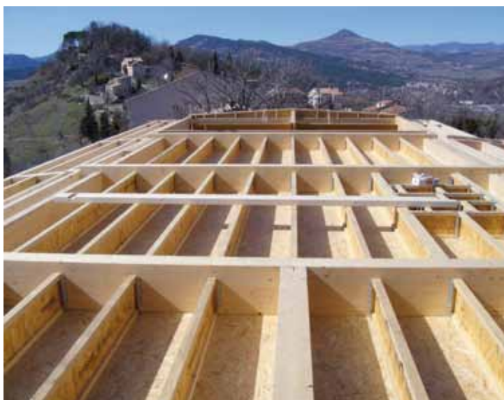
Toiture prête à recevoir des granules de liège puis fermée grâce à des panneaux photovoltaïques amorphes.
