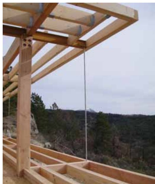
Détail des IPN, du tirant et du balcon. Une poutrelle en I à profil normal (plus communément appelé IPN ou INP) est un type de profilé standardisé courant de poutre à âme pleine en forme de I de section constante portant sur sa semelle inférieure.
