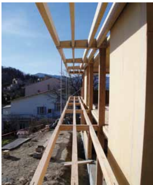
Tout le balcon Sud avec les suspentes métalliques pour le tenir.
