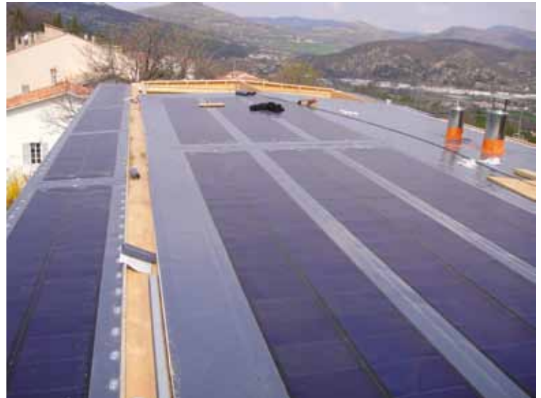
Membrane photovoltaïque permettant la production d'électricité. Le bâtiment est ainsi qualifié « à énergie positive ».
