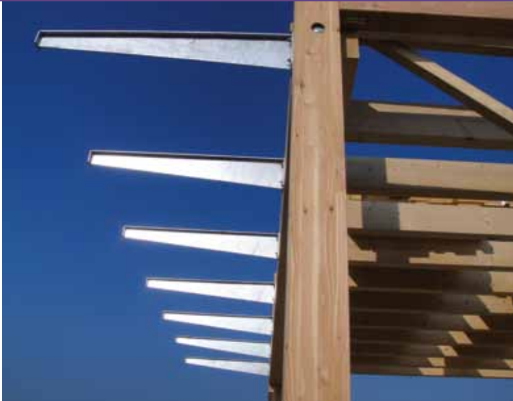
Les consoles métalliques permettent de gérer le porte-à-faux de la terrasse.
